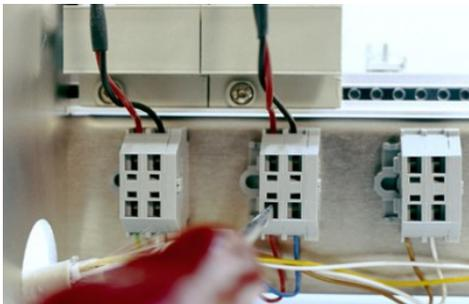
Klemmenbetätigung mittels Schraubendreher
